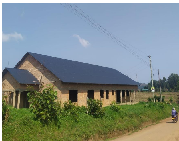
... in via di completamento.
